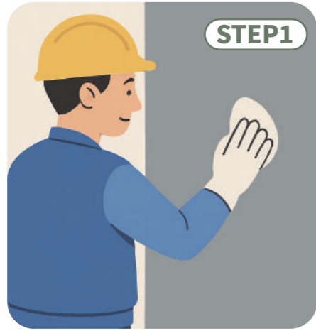
STEP1 牆面清潔與確認平整度
