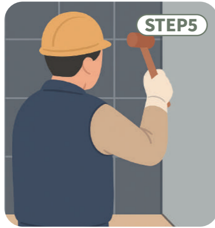
STEP5 安裝上牆後並使用橡皮槌加固
